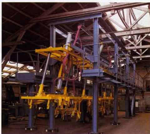
1975 TRANSFERT AERIEEN POUR ASSEMBLAGE CAISSE
